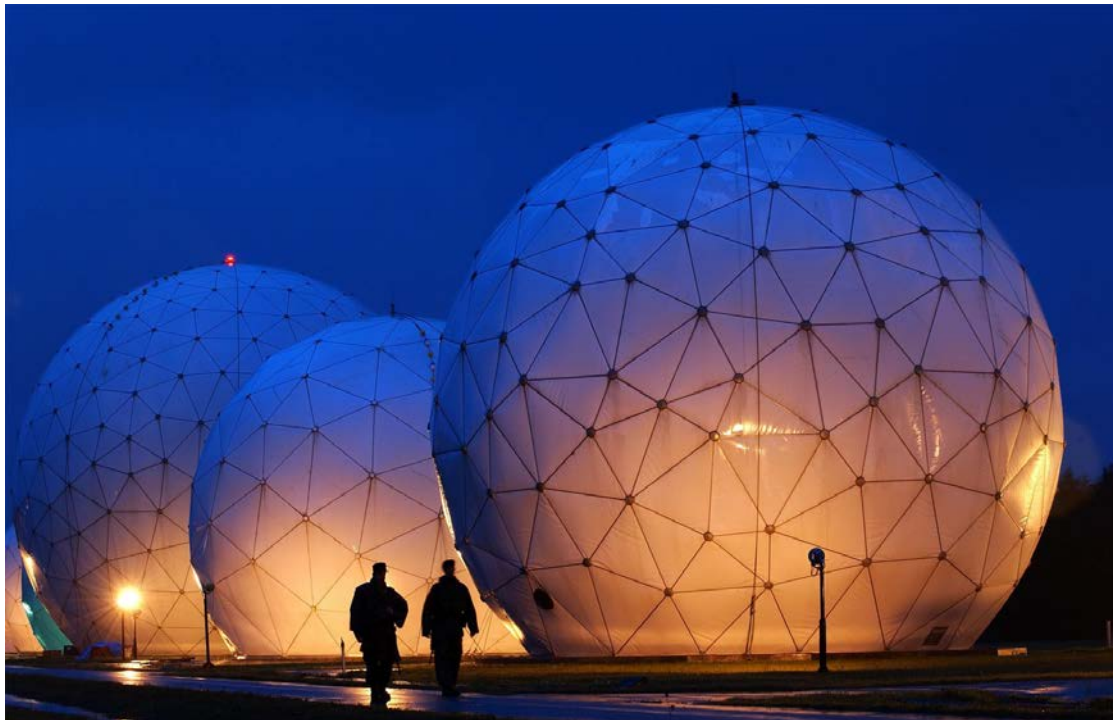
"Radômes" au Centre des opérations de cryptologie à la base aérienne de Misawa au Japon. Radôme est la contraction de "radar dôme", un boîtier étanche utilisé pour protéger les antennes. © Preston Keres - Source : www.kereskreatives.com .
